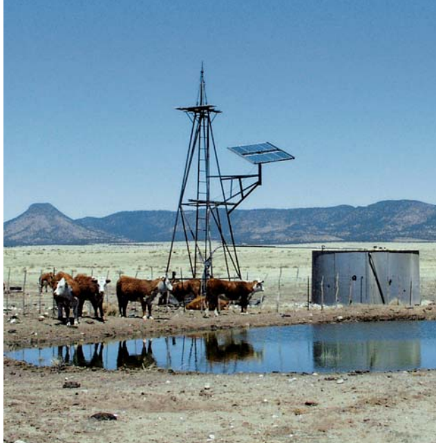
Una tipica stazione di pompaggio alimentata ad energia solare negli USA che ha sostituito un vecchio mulino a vento.
